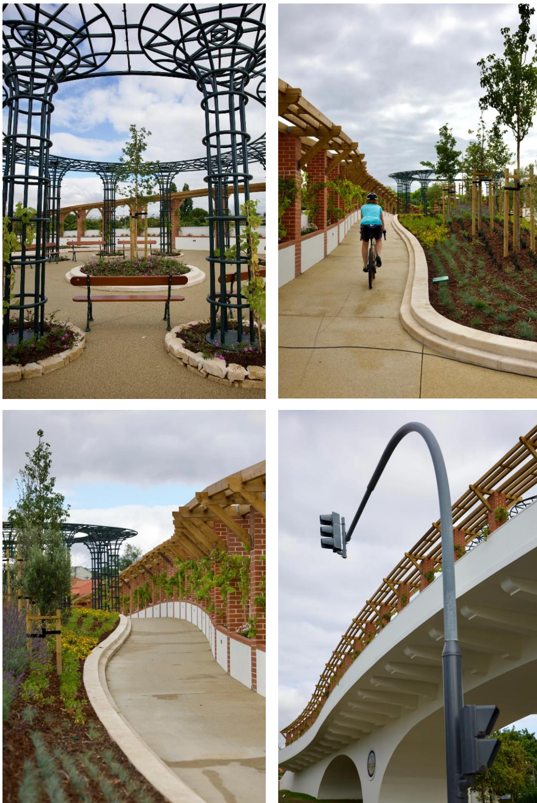
Figura 1-2 Ponte Ciclopedonal da Avenida Almirante Gago Coutinho
