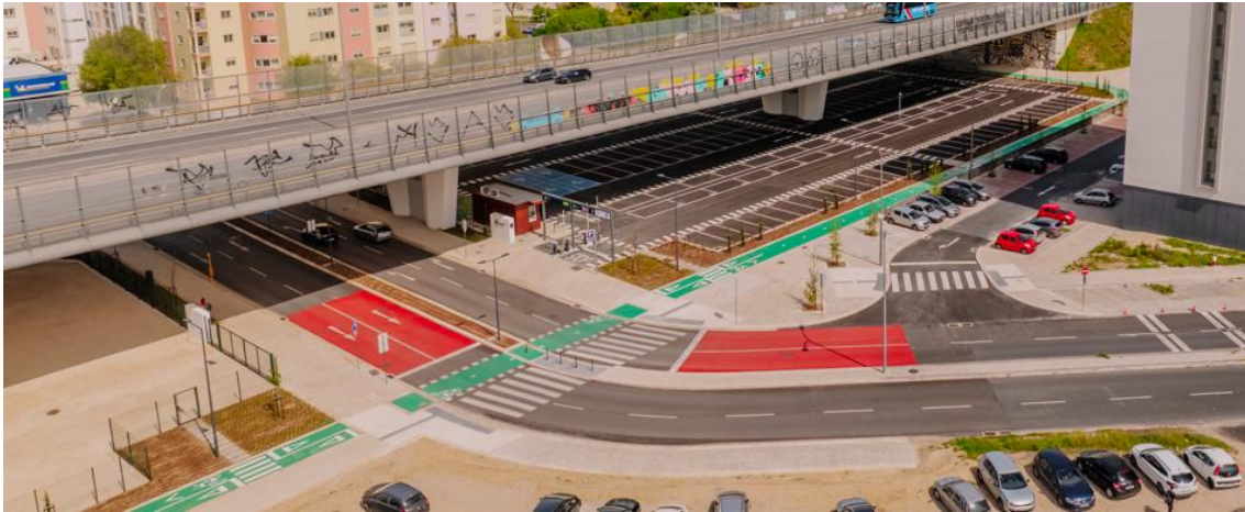
Figura 1-4 Troço de ciclovia na Azinhaga da Cidade
