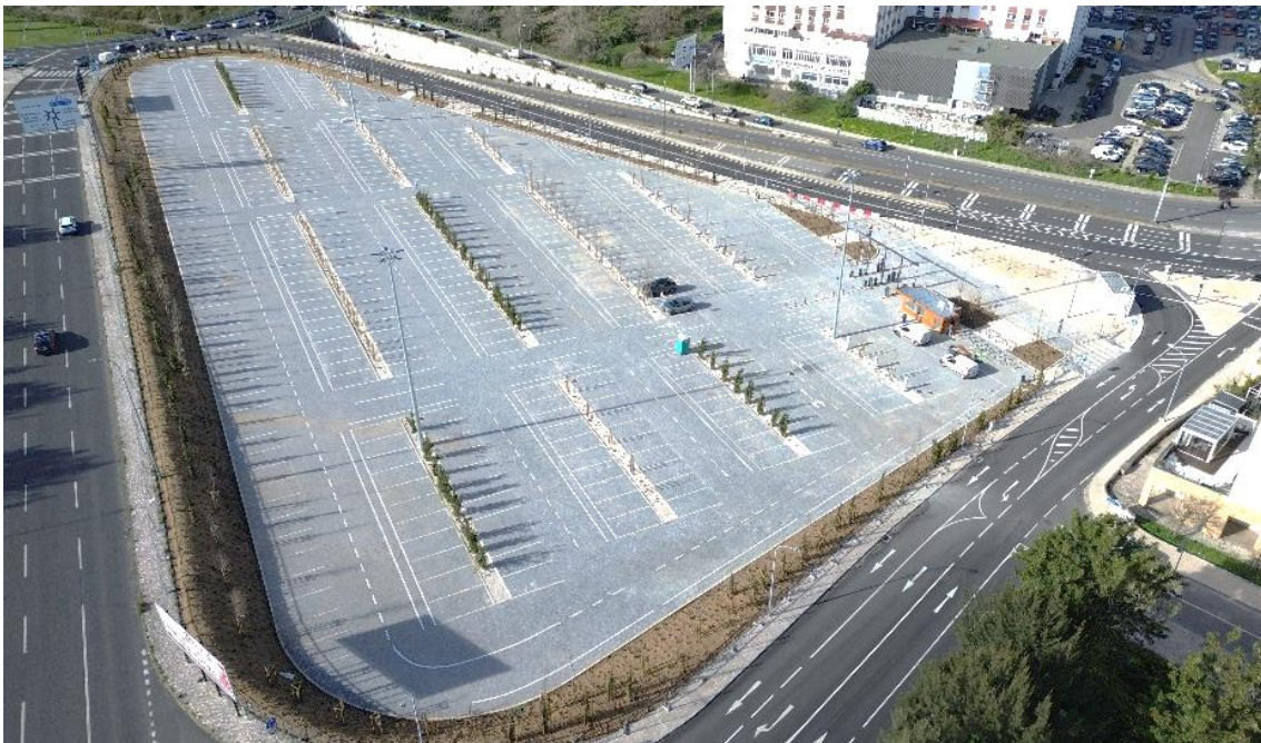
Figura 2-21 Parque de Estacionamento Pontinha Sul / Condes de Carnide
